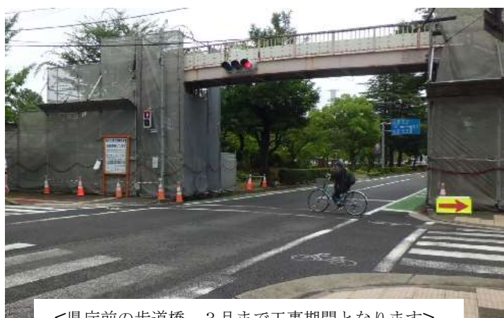
<県庁前の歩道橋。3月まで工事期間となります>
