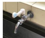
市と国からの感染拡大防止のための特別予算を使って、本校手洗い場とトイレの水道の蛇口を回転式からレバー式に交換しました。手のひらで握らなくても手の甲や肘で水道の開け閉めができます。
